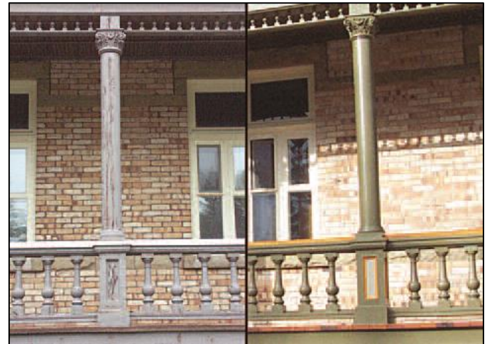
Colonnes de la galerie avant et après restauration
