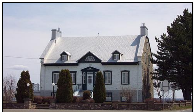
Le presbytère de Cacouna. Photo : Yves-Marie Mélançon, 2005.
