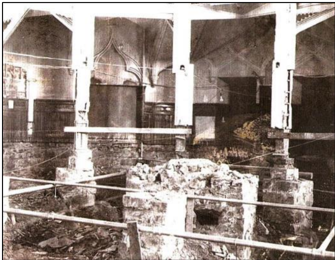
En 1967, le chœur de la cathédrale durant sa cure de rajeunissement. C'était après le démontage des planchers et avant le coulage d'une dalle de béton. Photo : Philippe Michaud, collection privée.
