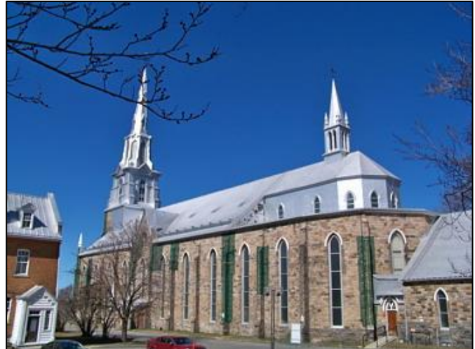
La toiture de la cathédrale nécessite d'importants travaux, c'est bien évident! Photo : Yves-Marie Mélançon, 2021.
