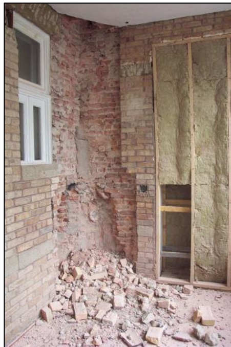
Une des pièces du mur ouest (au 2 e étage) qui ont été démolies et remplacées par un escalier partant du sous-sol jusqu'au 4 e étage
