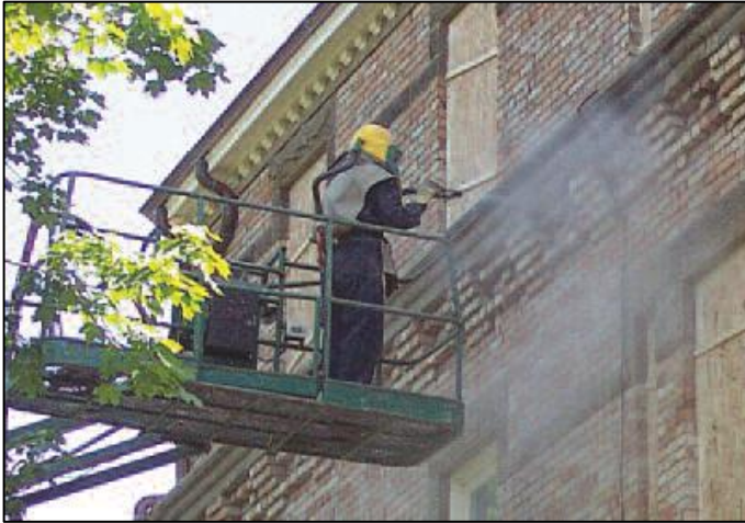
Nettoyage des murs extérieurs au jet de verre broyé
