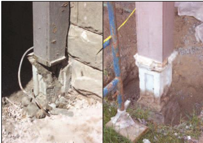
Piliers de la galerie avant les travaux
