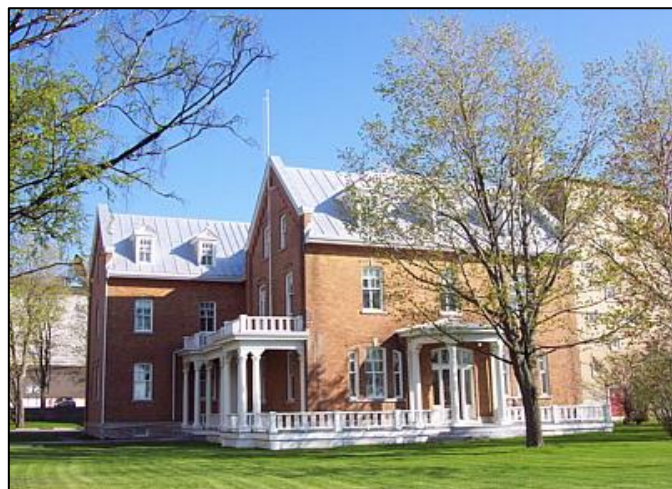
Le presbytère de la paroisse cathédrale. Photo : Yves-Marie Mélançon.
