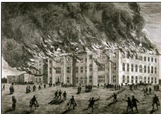
Incendie du 2 e séminaire de Rimouski, le 5 avril 1881. L'opinion publique , Vol. 12, n o 18, 5 mai 1881, p. 207. (Voir aussi le Billet #558.) Source : https://numerique.banq.qc.ca/patrimoine/details/52327/2069904?docsearchtext=incendie%20du%20s%C3%A9minaire
