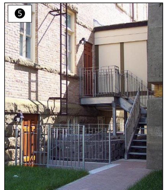
Travaux complétés pour les sorties de secours de la cafétéria, au sous-sol, ainsi que de l'escalier de l'est, au 1 er étage.
