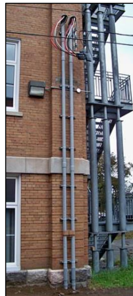
À l'extérieur, sur l'aile nord (côté est), la nouvelle entrée électrique. Photo : Yves-Marie Mélançon.
