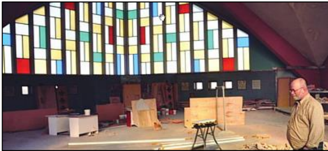
Les travaux de transformation de l'église Saint-Yves n'ont guère progressé depuis l'automne 2009. Photo : Ernie Wells, Le Progrès-Écho, 19 janvier 2011, p.5. Courtoisie
