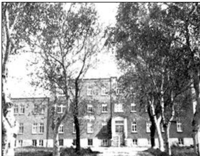
La « Maison Sainte-Thérèse » des Sœurs Missionnaires de l'Immaculée-Conception construite en 1931. Photographie inconnu. Source : Centre Saint-Germain , juillet-août 1945, p. 58.
