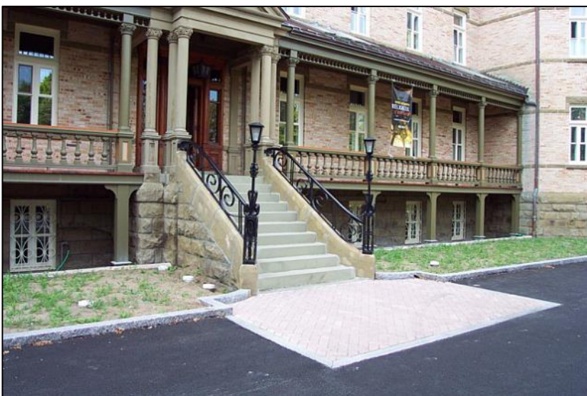
L'escalier restauré et l'entrée principale réaménagée
