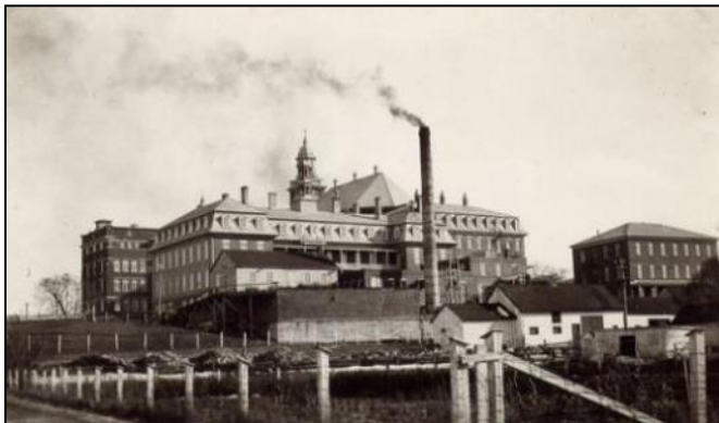
Vu du fleuve : avec au premier plan le couvent-école des Sœurs de la Congrégation de Notre-Dame , soit le 4 e Séminaire. En arrière-plan : l'aile-est et la toiture de la chapelle du 5 e séminaire. Au second plan, à l'extrême droite, le 2 e couvent des religieuses, construit en 1915, suivi de la buanderie, à gauche. Photographie inconnue. CEDAD, Fonds André-Albert Dechamplain, 14B4, no 538-7.
