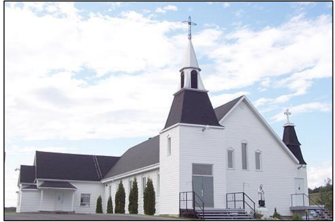
L'église au revêtement de fibres de bois de Saint-Vianney. Photo : Jean-François Mélançon, 2002.
