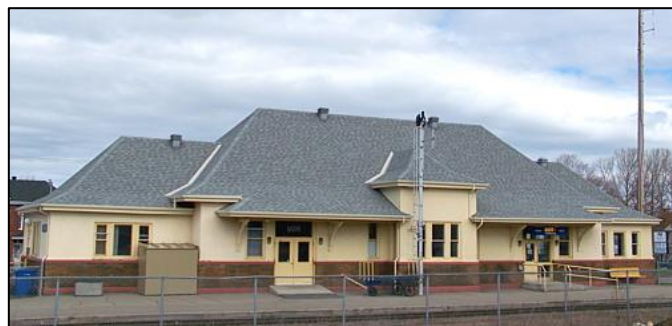
La vieille gare du Canadien National construite en 1937. Photographe : Yves-Marie Mélançon.
