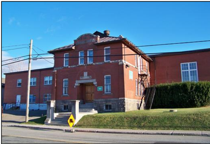
Situé au 65 est de la rue Saint-Jean-Baptiste, l'ancien Manège militaire existe depuis 1910-1911, avant la guerre de 1914-1918. Photographie: Yves-Marie Mélançon.
