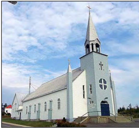
L'église de Sainte-Rita au revêtement de stucco et d'imitation de pierre. Photo : Yves-Marie Mélançon, 2002.
