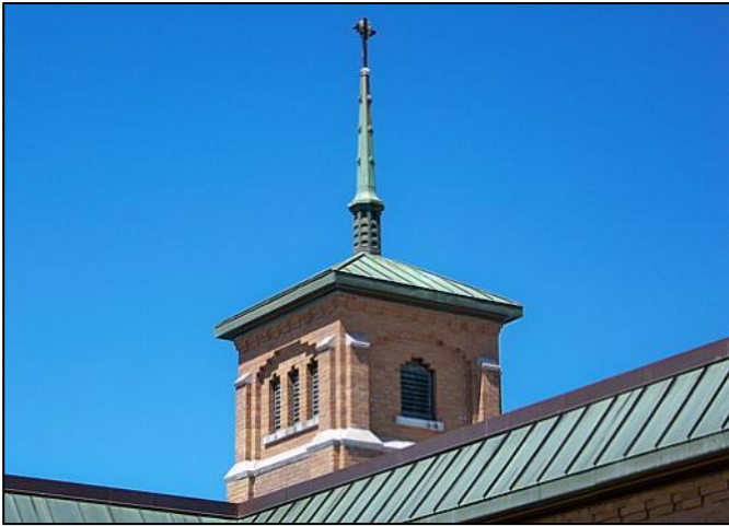
Une vue du campanile sur la toiture. Photo : Yves-Marie Mélançon.
