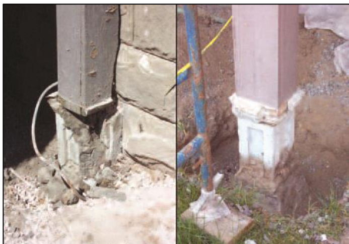
Piliers de la galerie avant les travaux
