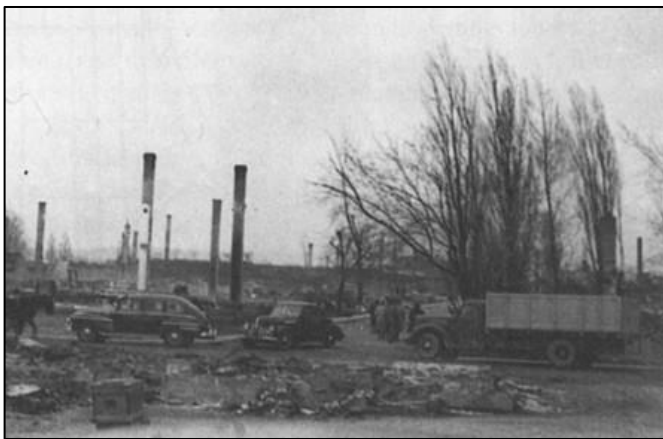
Aux jours qui ont suivi le sinistre de mai 1950, seules les cheminées émergent des décombres. Photographe inconnu. ARSR.
