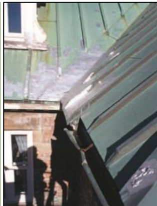
Noûe 1 avant les travaux
