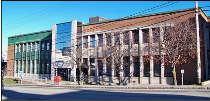
Ancien bureau de poste, édifice du gouvernement fédéral sur l'avenue de la Cathédrale. Photographie : Yves-Marie Mélançon.
