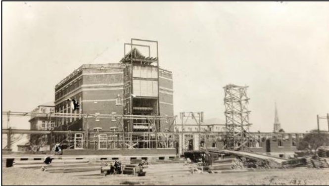
Le 5 e Séminaire en construction. Photo : courtoisie, Cégep de Rimouski.
