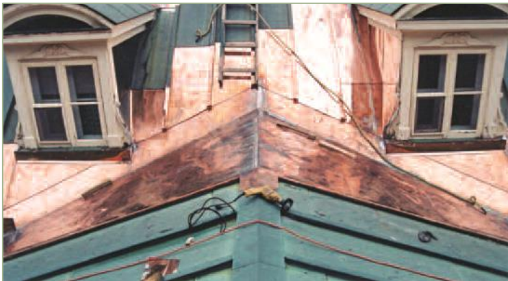
Réfection d'une partie de la toiture
