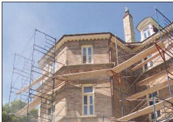
Évidement des joints de maçonnerie
