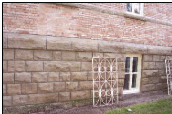
Le rejointoiement de la maçonnerie est terminé
