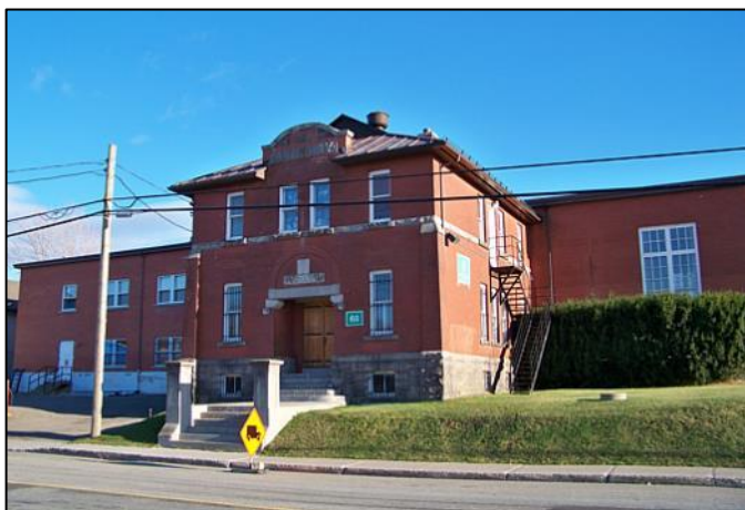
Situé au 65 est de la rue Saint-Jean-Baptiste, l'ancien Manège militaire existe depuis 1910-1911, avant la guerre de 1914-1918. Photographie: Yves-Marie Mélançon.
