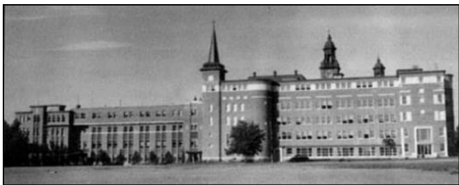
À l'extrême droite, la partie haute, depuis le campanile, correspond à l'École de commerce, construite en 1946-1947, qui partage ses locaux avec l'École normale Tanguay à partir de 1958. À l'extrême gauche, la partie visible de l'École d'arts et métiers, construite en 1941 et agrandie en 1944. Photographie inconnu. UQAR, Archives régionales, Fonds Huberte Garon.
