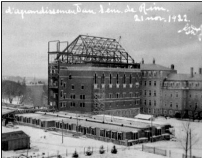
Travaux d'agrandissement du 4 e Séminaire réalisés entre 1922 et 1925. Photographie inconnue. Source : ARSR, 198.420, R-56.
