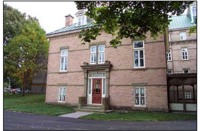
Travaux finalisés à l'arrière de l'archevêché
