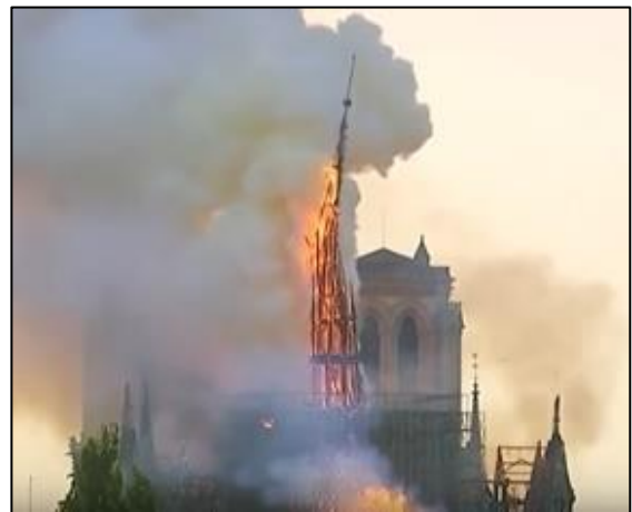
Notre-Dame de Paris : effondrement de la flèche en feu. Photo : Pascal Christiani. Courtoisie.
