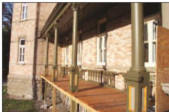
Restauration de la galerie avant
