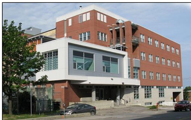
L' Hôtellerie Omer-Brazeau , située à l'angle des rues Saint-Louis et Sainte-Marie à Rimouski. Photo : ACEQ. Courtoisie
