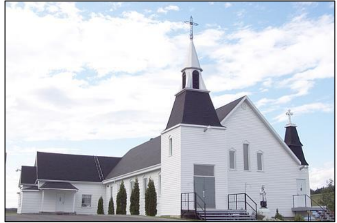
L'église au revêtement de fibres de bois de Saint-Vianney. Photo : Jean-François Mélançon, 2002.
